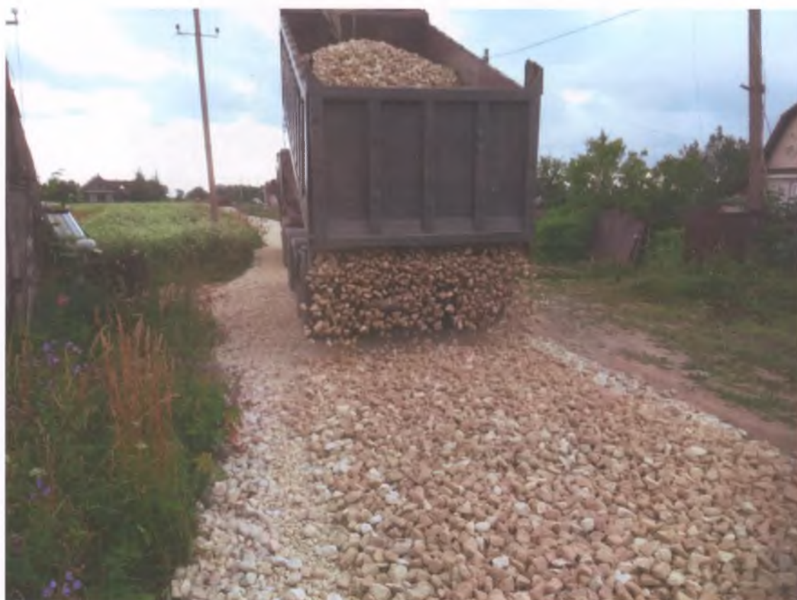
Устройство покрытий толщиной 15см при укатке щебня
