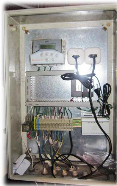
**Рисунок 1. Тепловычислитель марки ВКТ-7**
