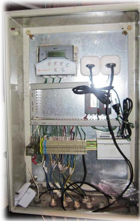
**Рисунок 1.2.9.1. Тепловычислитель марки ВКТ-7.**
