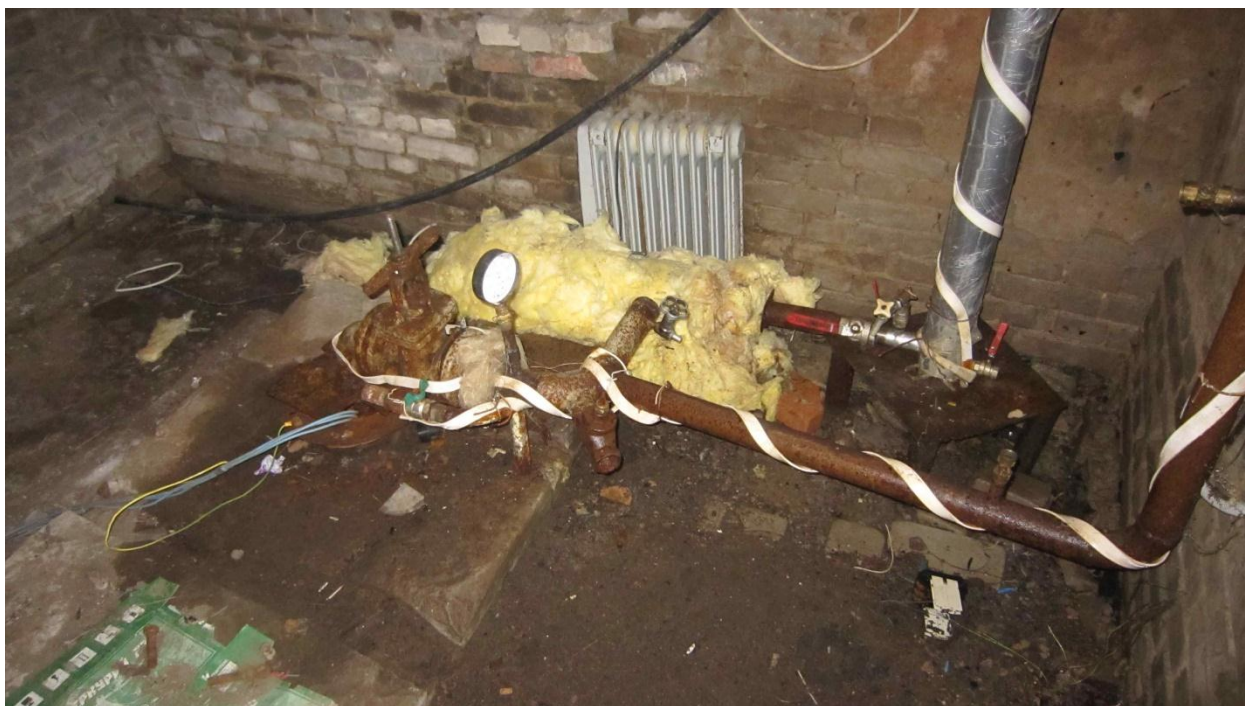
Рисунок 7 – Оголовок скважины, задвижка, манометр и установка обеззараживания воды
