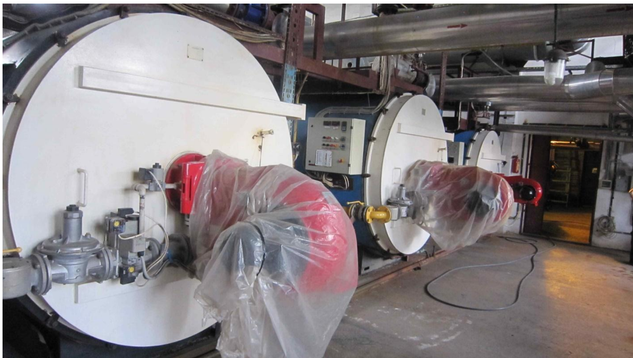
Рисунок 3 – Котлы «Турботерм»
