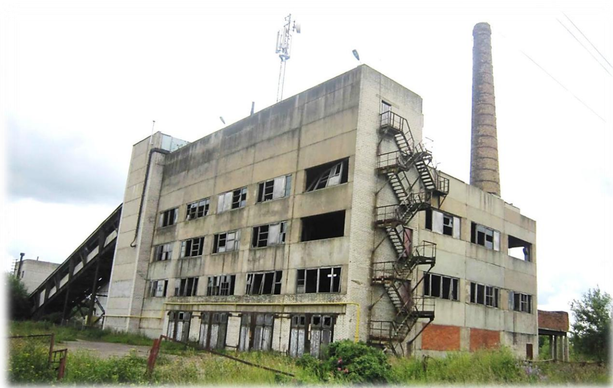
Рисунок 2 – Вид котельной с. Копорье
