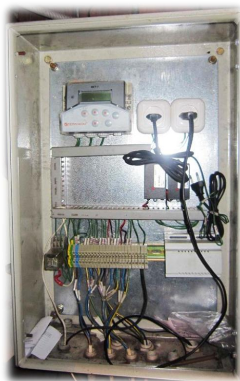
Рисунок 5 – Тепловычислитель марки ВКТ-7
