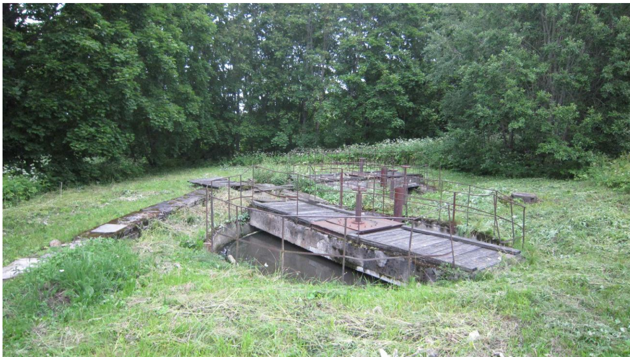
Рисунок 18 – Отстойники КОС
