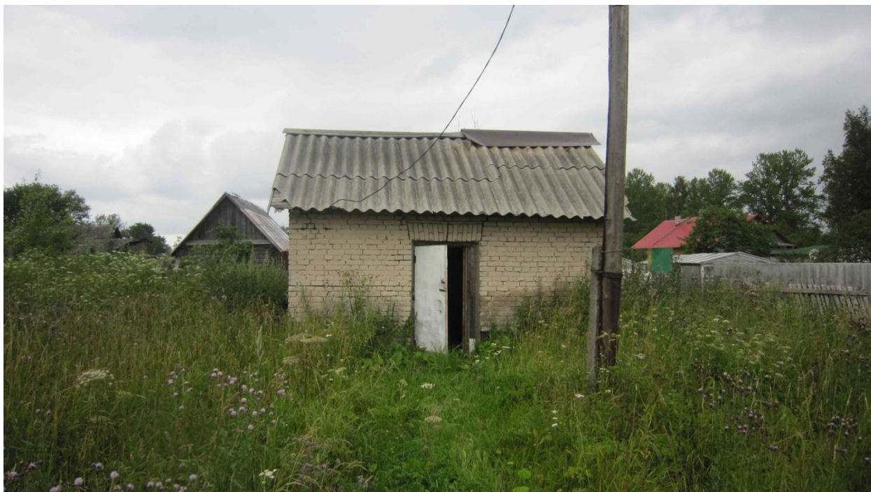
Рисунок 6 – Надземный павильон скважины в д. Ломаха
