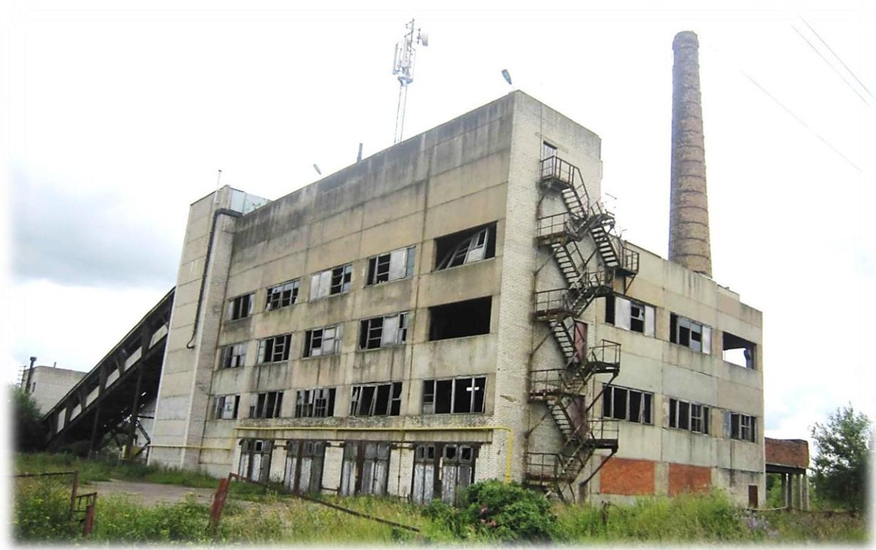
Рисунок 4 – Вид котельной с. Копорье
