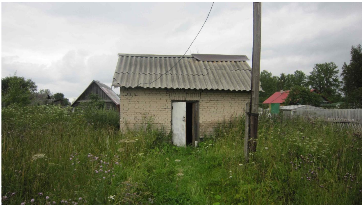
Рисунок 7 – Надземный павильон скважины в д. Ломаха
