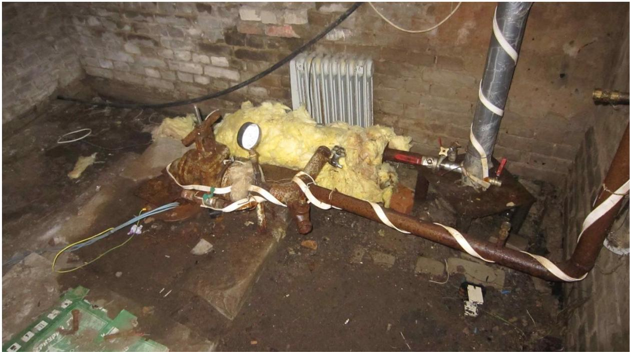
**Рисунок 3 – Оголовок скважины, задвижка, манометр и установка обеззараживания воды**
