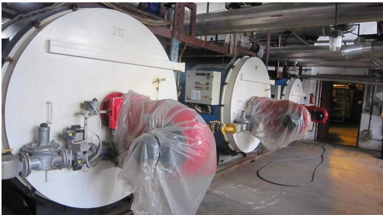
**Рисунок 5 – Котлы «Турботерм»**
