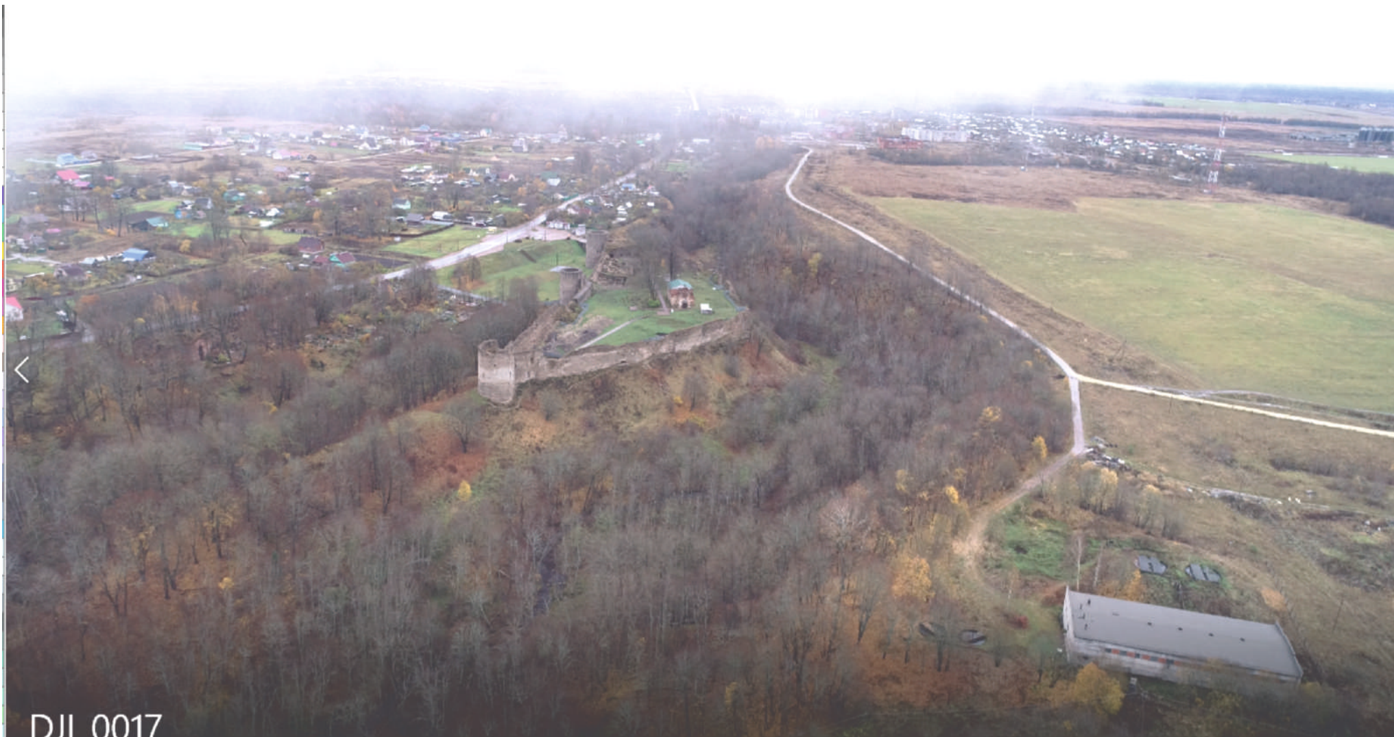
31. Вид с юга на территорию, окружающую объект культурного наследия федерального значения «Крепость с церковью», середина XV в., XVI-XVII вв. 27.10.2019 г.
