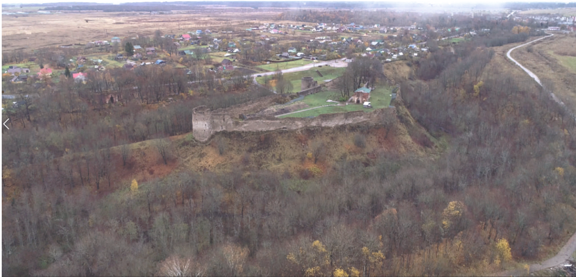
29. Вид с юго-запада на объект культурного наследия федерального значения «Крепость с церковью», середина XV в., XVI-XVII вв. и окружающую территорию. 27.10.2019 г. С восточной стороны расположена зона индивидуальной жилой малоэтажной застройки, с северо-западной стороны - лесной массив.
