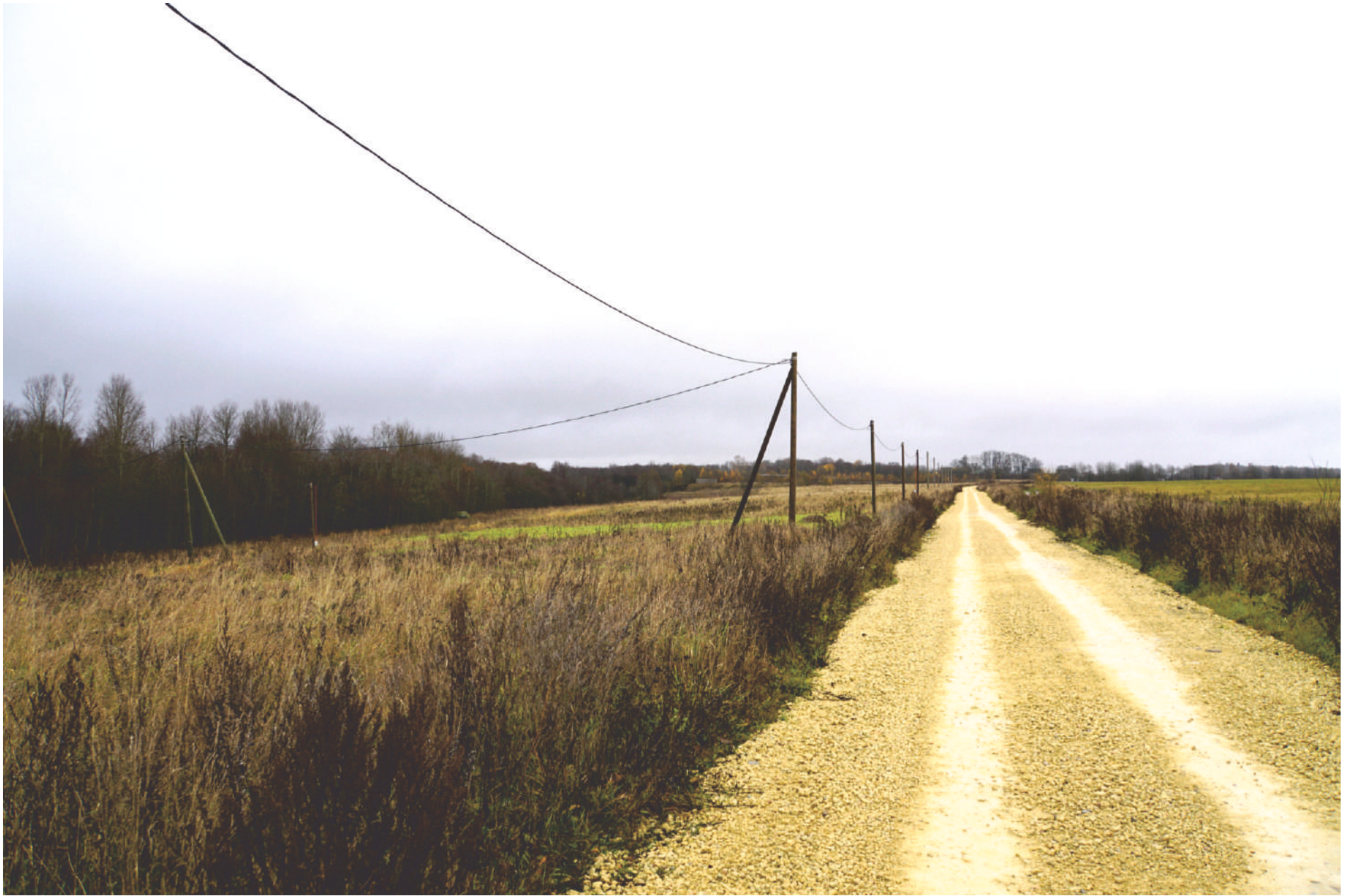
1. Вид с юго-запада на объект культурного наследия федерального значения «Крепость с церковью», середина XV в., XVI-XVII вв. 27.10.2019 г. Расстояние до объекта 900 м. Объект и территория объекта на данном расстоянии не воспринимается.
