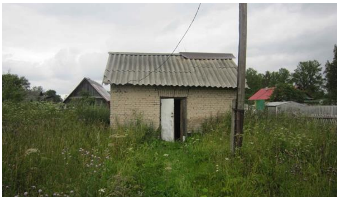
Рисунок 1.1.4.1-1 Внешний вид павильона скважины в д. Ломаха
